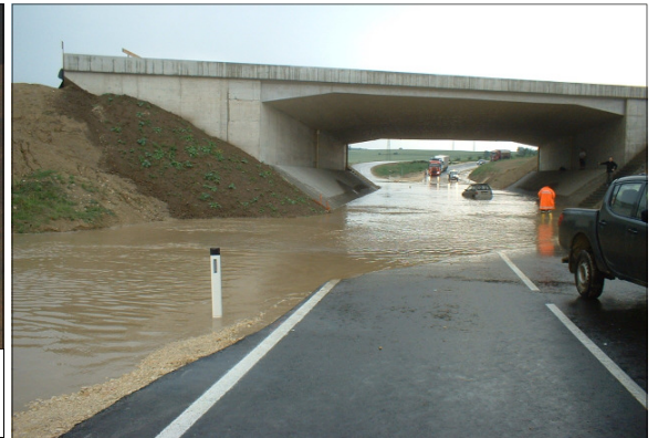
4.6.2008: Neue B7 unterhalb der A5 Autobahnunterführung überschwemmt
